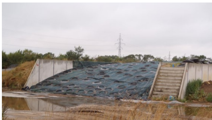
Trappe op til og gangareal langs med siloen sikrer mod fald.
